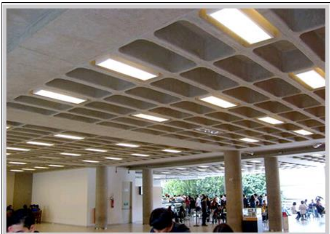
Figura 10 - Laje nervurada com vigas-faixa. Fonte: http://www.atex.com.br/pt/solucoes (2017).
